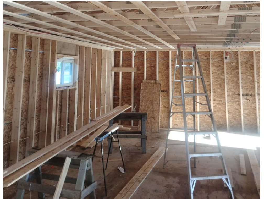
L'équipe de volontaires navals a apporté une contribution significative à la planification et à la construction du nouveau bâtiment.
