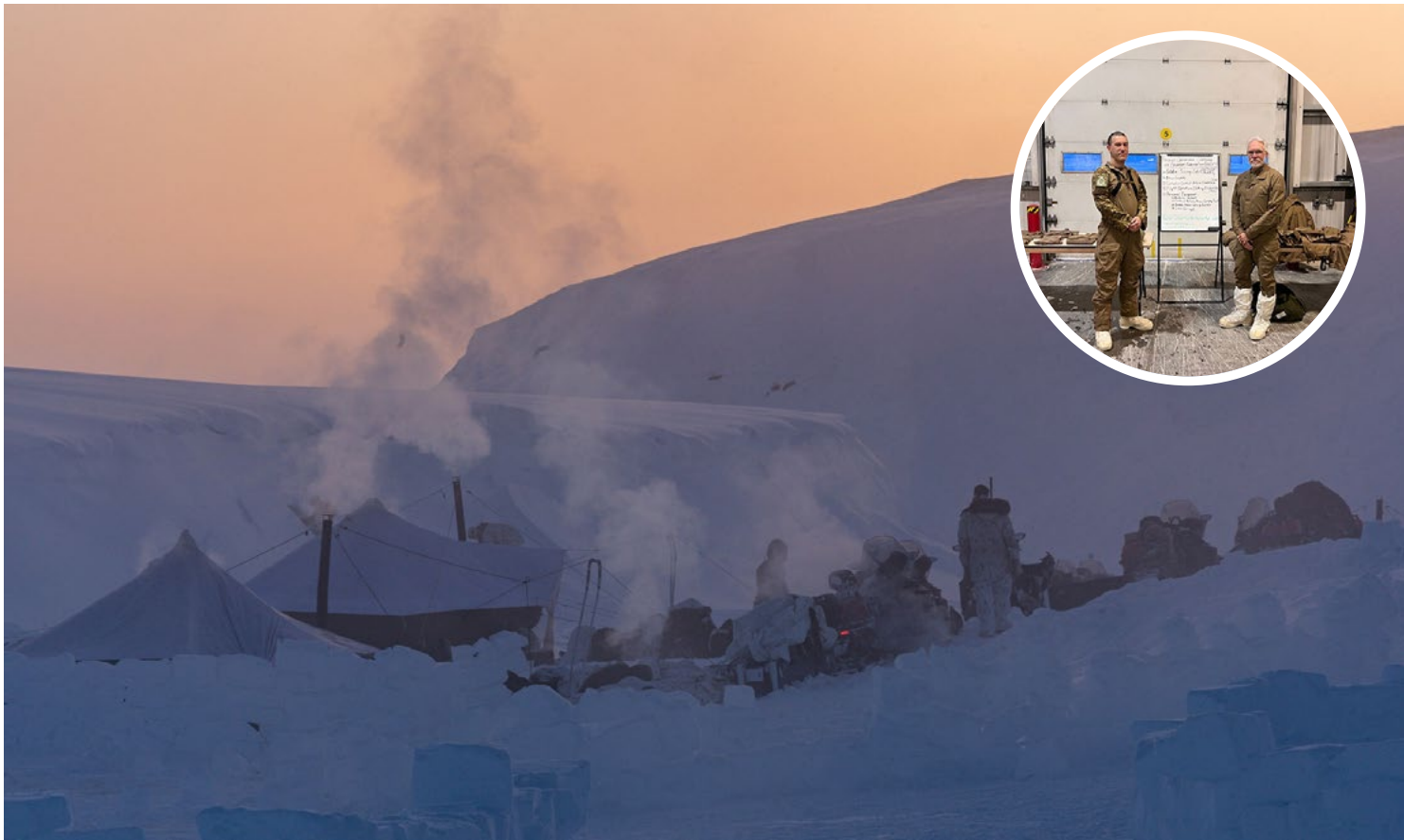
Les stagiaires de l'École de recherche et de sauvetage des Forces canadiennes (ERSFC) construisent des abris à Crystal City, dans la baie Resolute, au Nunavut, le 16 février.
