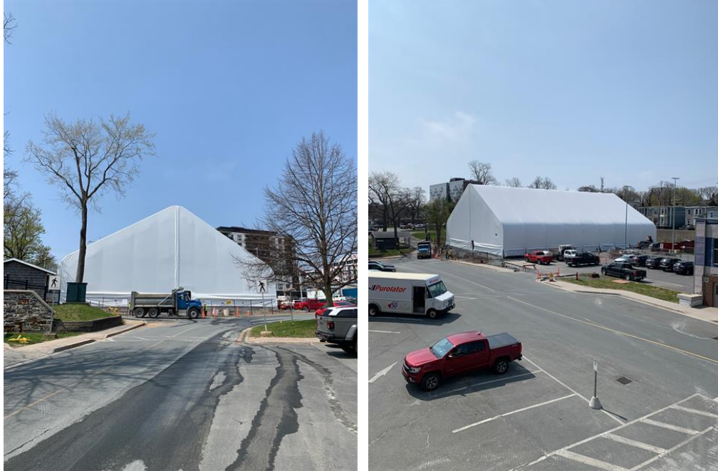
L'enveloppe en tissu du centre de conditionnement physique de Stadacona a été installée au printemps 2023.
