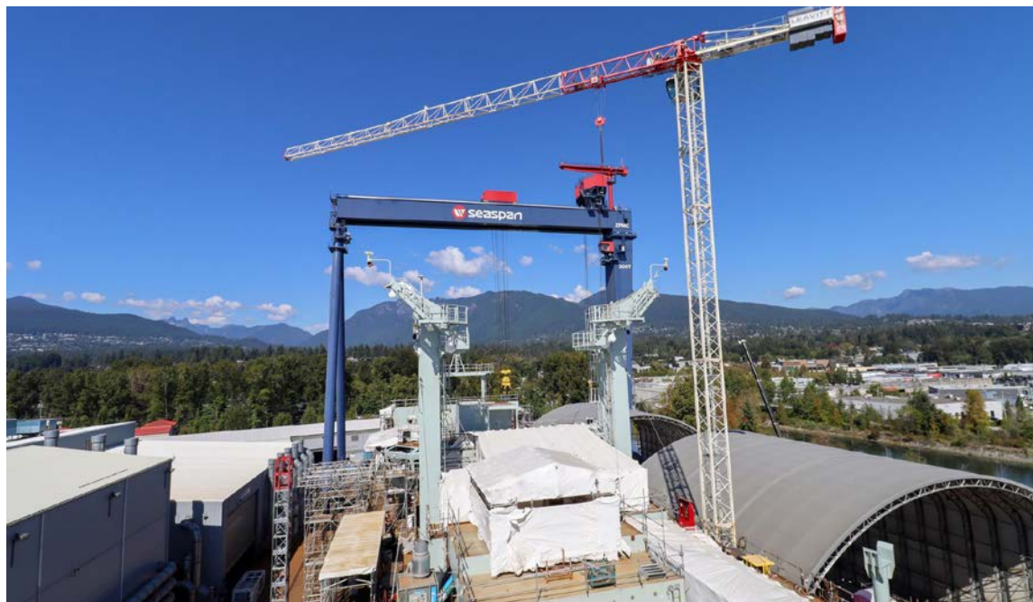
L'installation des postes de ravitaillement en mer sur le futur NCSM Protecteur a eu lieu au chantier naval Seaspan de Vancouver au début de l'automne.
