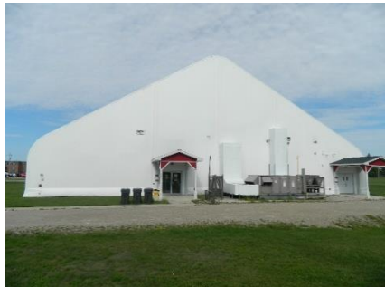
Installation de conditionnement physique à la BFC Borden
